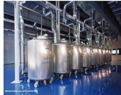
Tanks zur Kryolagerung von Biomaterialien bei -140 °C.
