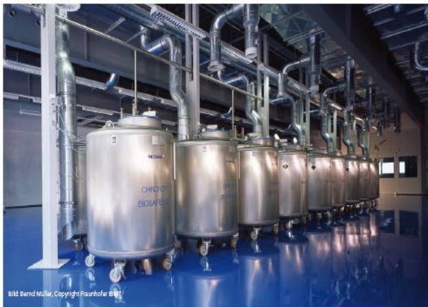
Tanks zur Kryolagerung von Biomaterialien bei -140\text{ }^{\circ}\text{C} .
